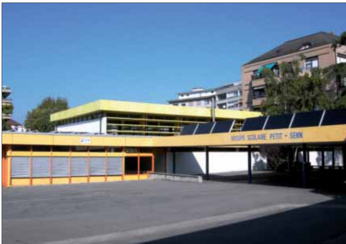
La pose de panneaux thermique et photovoltaïques permettra à l'école du Petit-Senn d'économiser un tiers de sa consommation énergétique globale annuelle.
