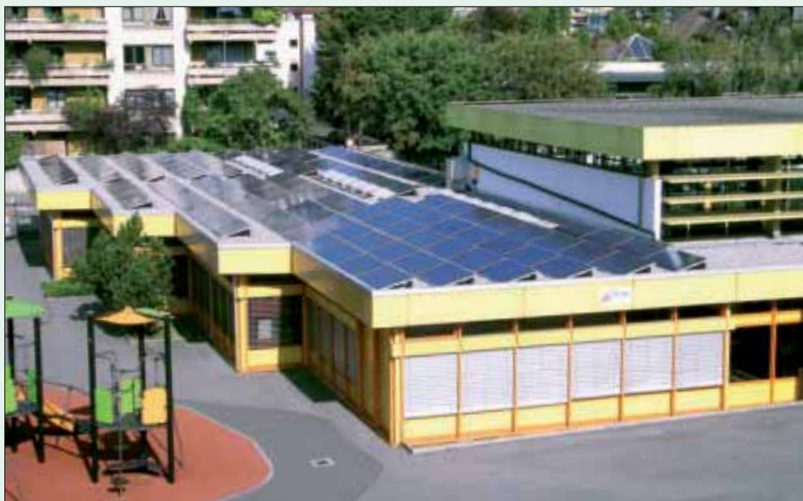
128 panneaux photovoltaïques produisent annuellement 30 000 kWh.
