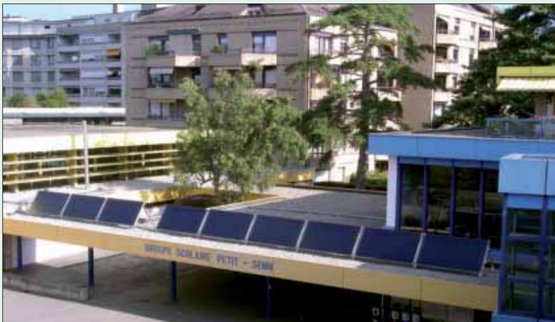
20 m 2 de panneaux solaires thermiques contribuent à la production de la majorité de la consommation d'eau chaude sanitaire de l'école.
