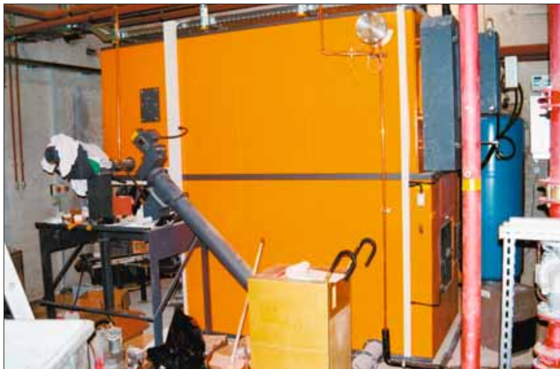
Vue de l'imposante centrale de chauffage à bois installée dans le sous-sol du bâtiment érigé dans l'enceinte du Service des parcs et promenades, en bordure du parc Stagni.
